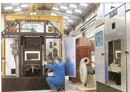
Montaż pieca monoblok
